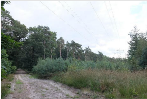
Afbeelding 3.13 | Verjonging onder de hoogspanningsmasten op het terrein van ASR.
