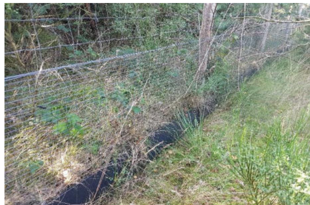
Afbeelding 12.2 | Hekwerk met reptielenscherm dient als geleiding van en naar het ecoduct.
