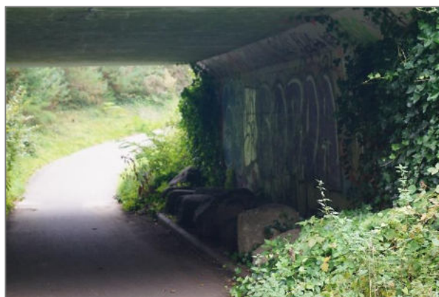
Afbeelding 5.22 | Fietstunnel onder spoorlijn Den Dolder-Amersfoort geschikt als faunapassage.
