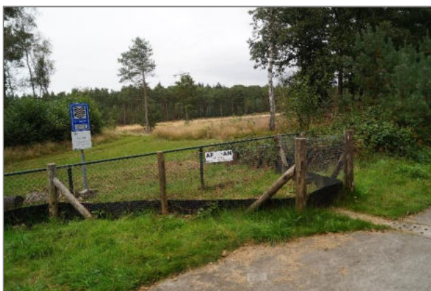
Afbeelding 5.21 | Faunatunnel met rooster onder fietspad Heezerspoor Oostzijde.
